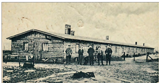
Rys. 36. Baraki dla robotników leśnych w Leśnictwie Czerwieńce – pruska część Puszczy Noteckiej Źródło: archiwum autora.
