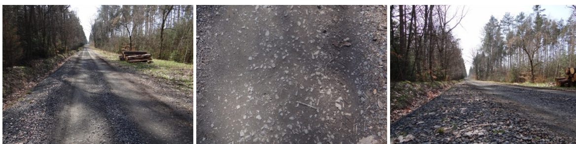
Rys. 6. Dojazd pożarowy nr 15 – odcinek badawczy nr 15/2017
