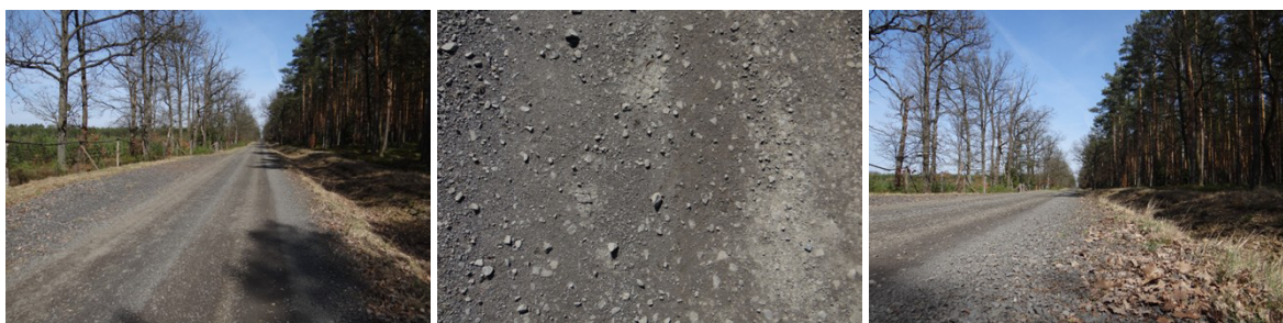
Rys. 5. Dojazd pożarowy nr 15 – odcinek badawczy nr 15/2016
