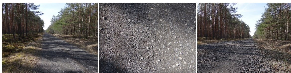
Rys. 4. Dojazd pożarowy nr 63 – odcinek badawczy nr 63/2015
