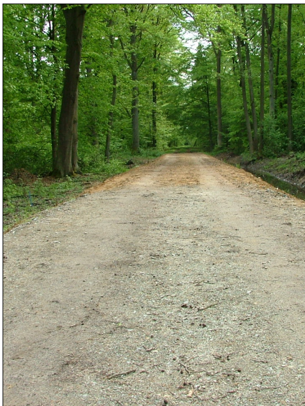
Fot. 2. Widok odcinka doświadczalnego w dniu przeprowadzenia pomiarów (fot. S. Grajewski)
