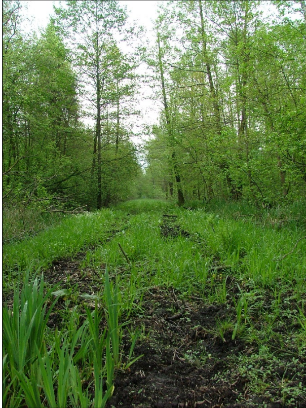
Fot. 1. Widok z terenu budowy odcinków doświadczalnych (fot. S. Grajewski)
